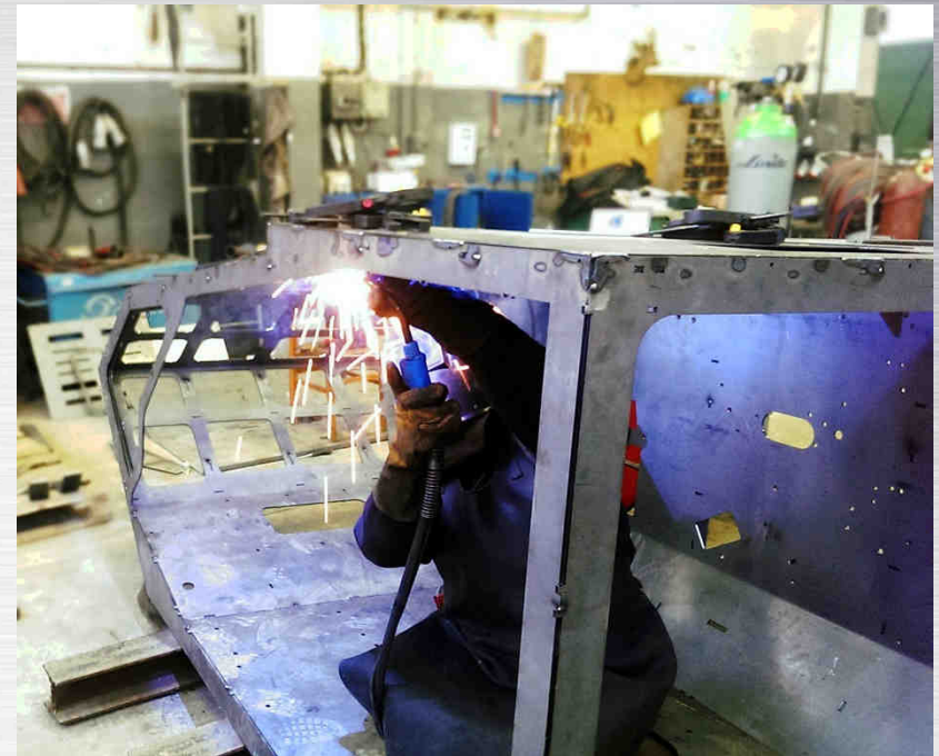
Proces spawania cienkościennej blaszanej konstrukcji przestrzennej.
